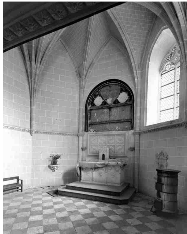
La chapelle après et avant restauration
