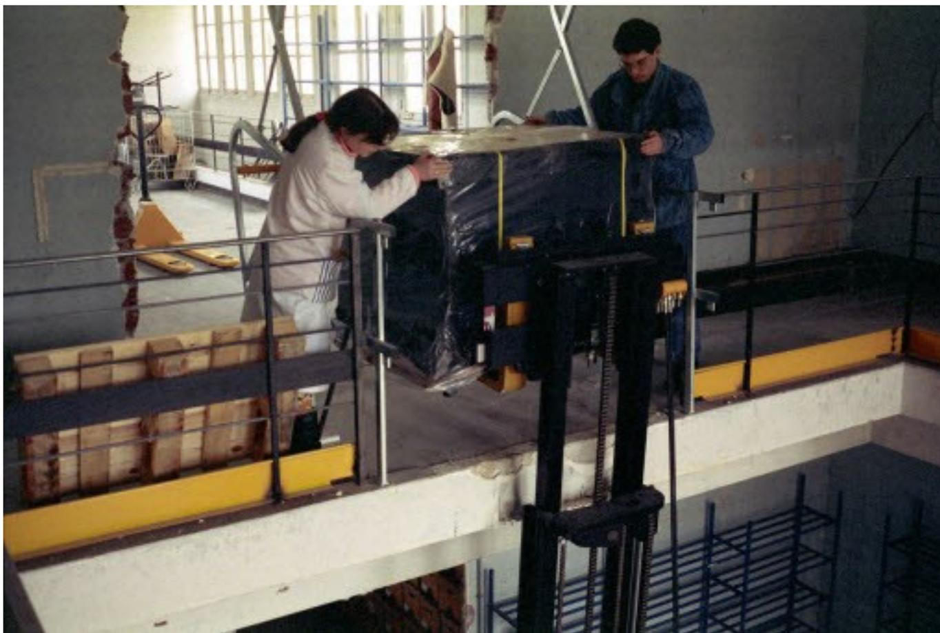
Elévateur construit ad hoc et passage pratiqué par abattage de cloison
