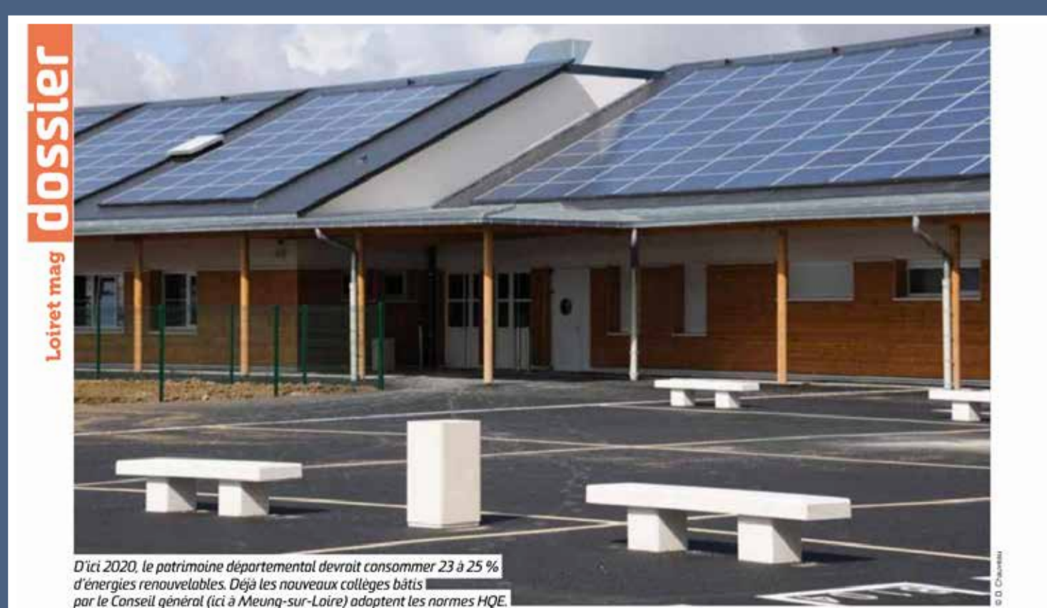
6 - Photographie de panneaux solaires sur les toitures du collège de Meung-sur-Loire, in Loiret Mag, janvier-février 2014. (Arch. dép. du Loiret, 714 PR 1)
